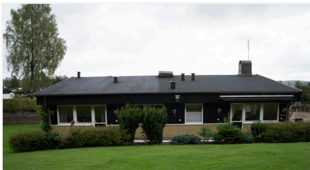
Tak på villa i Kinna som behandlats med Prebona DuraClean.
